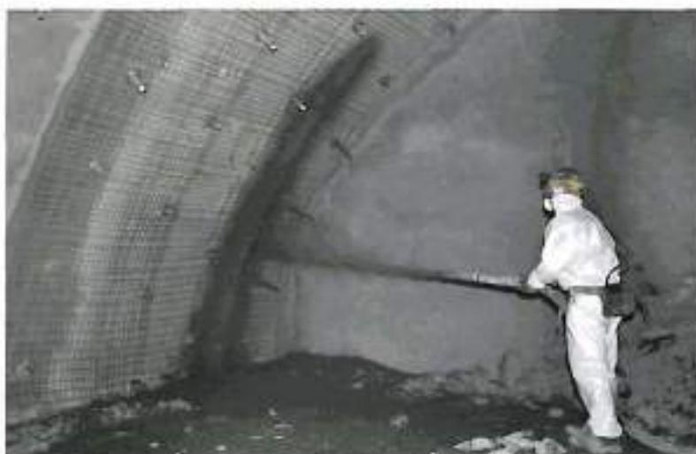
**Bild 27. Wenig Rückprall beim Aufbringen des Spritzbetons.**
