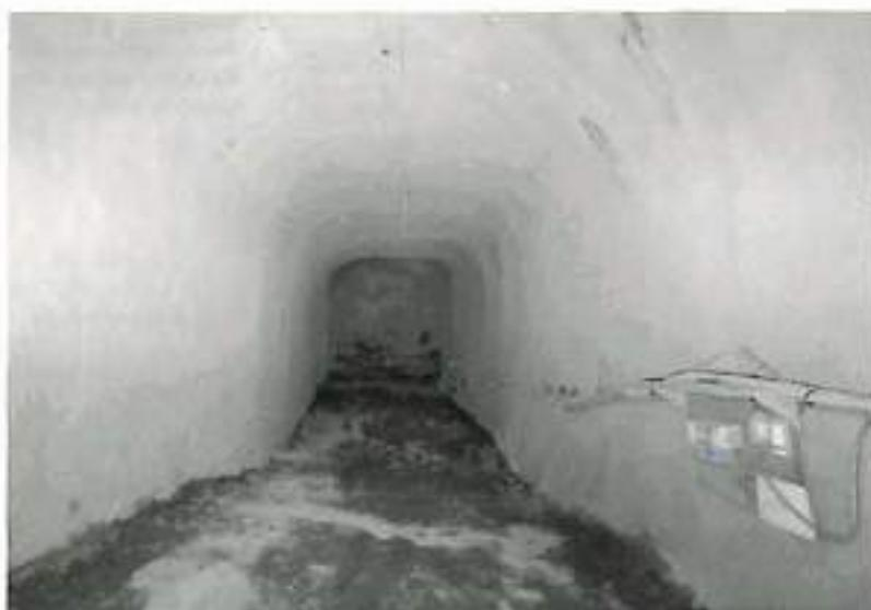
Bild 25. Pilotstrecke (Teilquerschnitt Ia) nach Fertigstellung.
